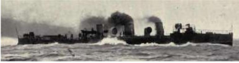
400/445 т, 65,5х6х2,7 м. ПТ - 4, 33 уз. Эк. 63 чел. 1 - 76 мм, 5 - 57 мм, 2 ТА 457 мм.
