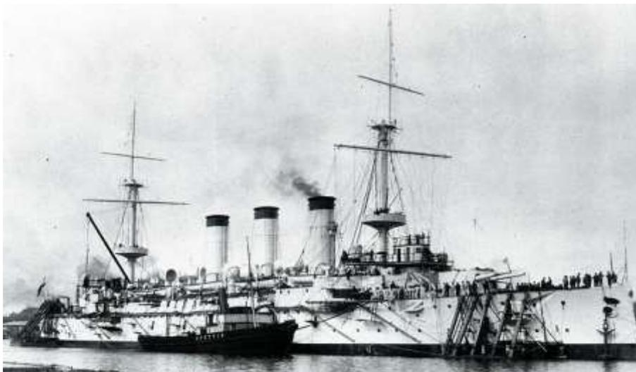
9735/10 300 т, 132,3х19,6х7,25 м. ПМ - 2, 24ПК, 15 500 л.с. = 20уз. 600/1200 т уг. Броня: пояс 178 мм, верхний пояс 127 мм, башни 150 мм, барбетты 150 — 100 мм, казематы 150 — 50 мм, палуба 63 мм, рубка 350 мм. Эк. 698 чел. 4 - 203 мм/40, 12-152 мм/40, 16-76 мм/40, 4 ТА 457 мм.
